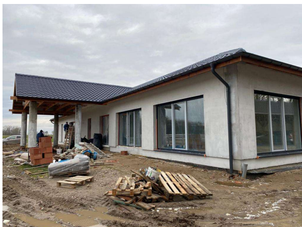
Fot. 1. Działka o nr 137 – widok w stronę północną i budynek usługowy opieki nad osobami starszymi w budowie.
